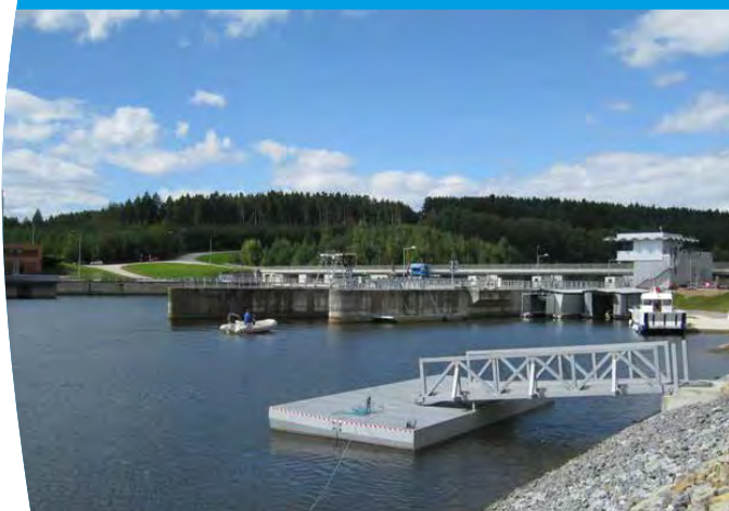
◀ Hráz Vodního díla Hněvkovice
