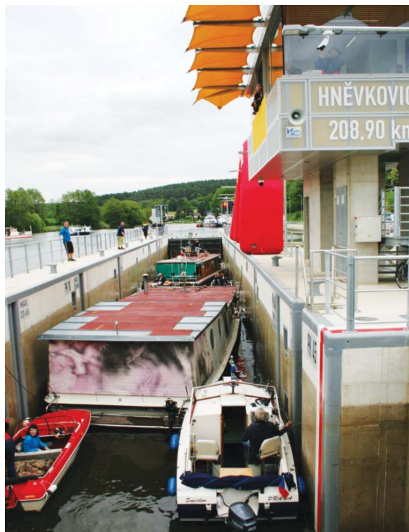
Plavební komora Hněvkovice praská ve švech
