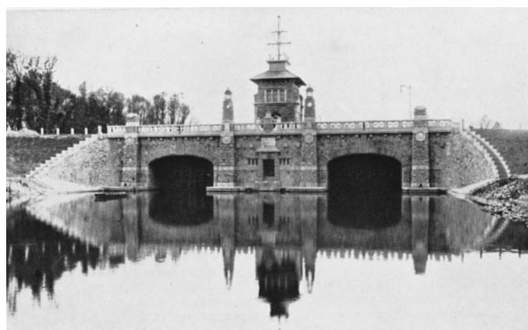
Spodní ohlavi plavebních komor v Hoříně (1905)
