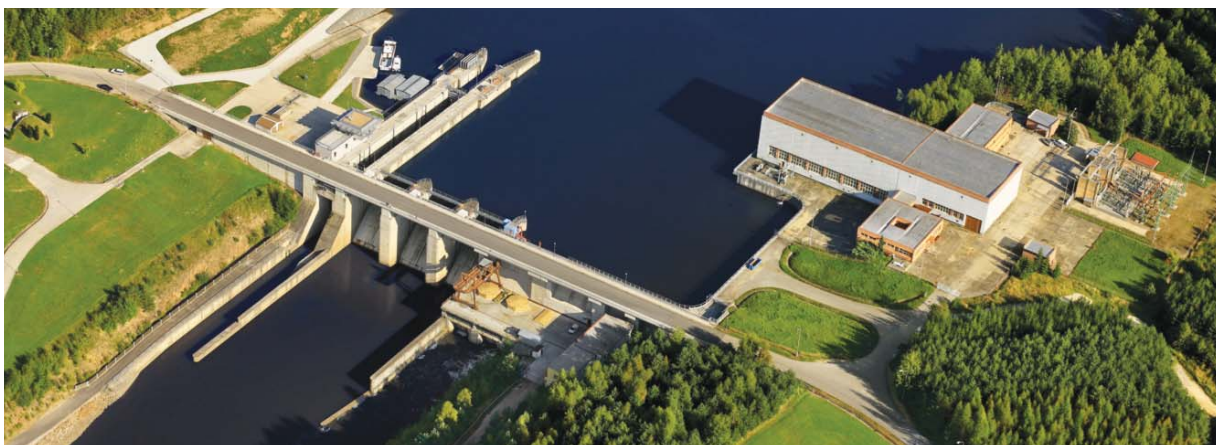
Plavební komora na hrázi vodního díla Hněvkovice překonává spád 15 metrů
