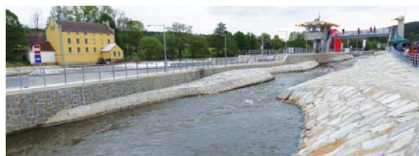
Rybí přechod na jezu Hněvkovice (2017)
