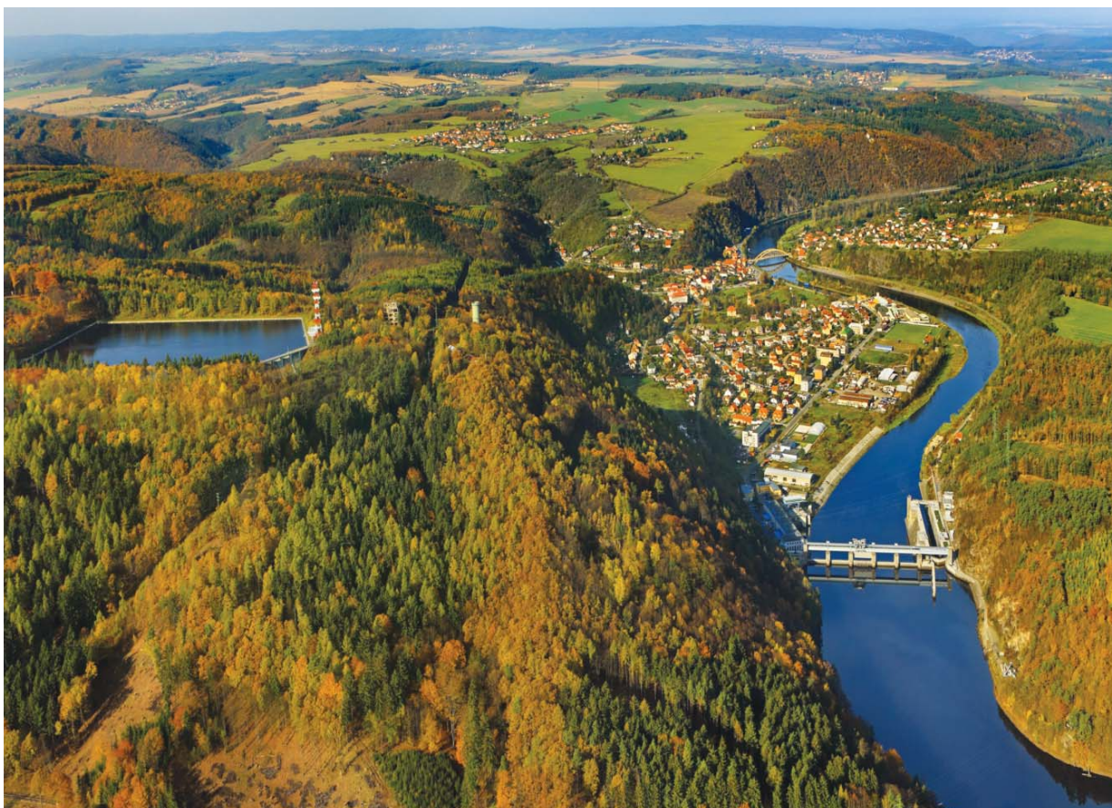
Vodní dílo Štěchovice a přečerpávací elektrárna
